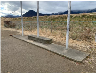
④掲揚ポール撤去
