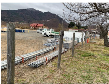
C 木杭撤去
