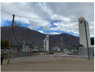
A バックネット撤去
