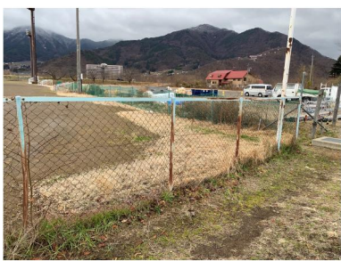
E 東側メッシュフェンス撤去
