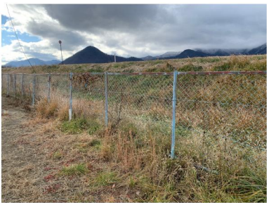
②西側メッシュフェンス撤去
