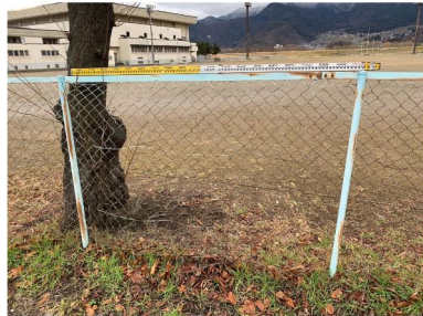
②東側メッシュフェンス撤去
