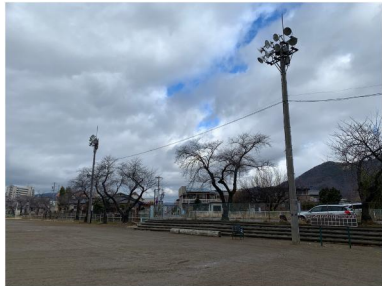
①サクラ伐採 ③照明柱撤去
